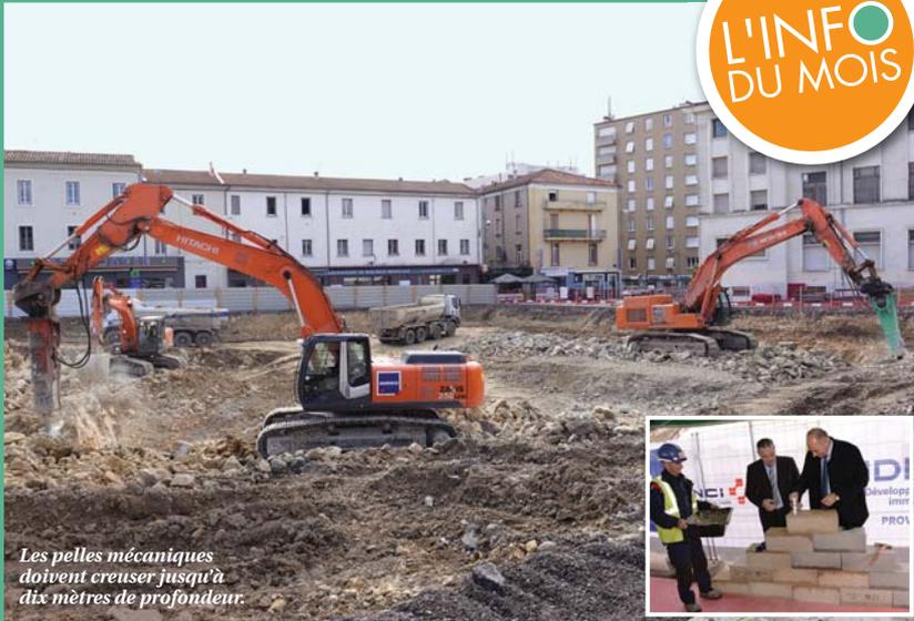
Les pelles mécaniques doivent creuser jusqu'à dix mètres de profondeur.
