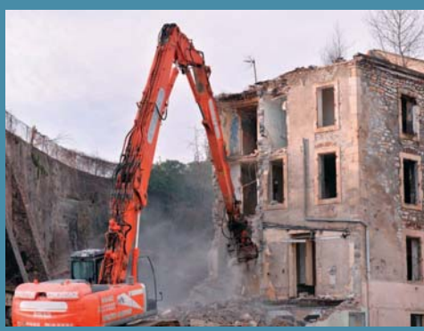
Ⓜ La démolition des trois premières maisons de la rue de La Roque va permettre de reconstruire une épicerie neuve et d'installer un ascenseur pour desservir le futur multiplexe.
