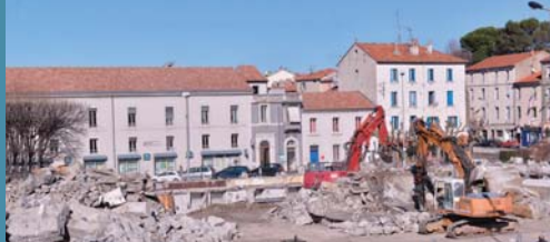
Ⓜ La démolition de l'ancienne cité administrative crée une ouverture du centre-ville sur les quartiers périphériques.
