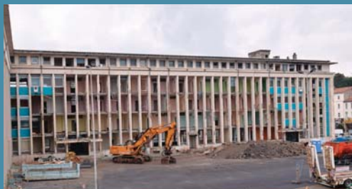
Ⓜ Les pelles mécaniques sont entrées en action le 6 janvier pour "grignoter" patiemment les 6 000 tonnes de béton.
