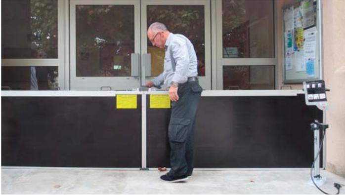
Le Syndicat mixte d'aménagement et de gestion des Gardons a respecté son engagement à équiper le foyer de la commune de batardeaux et de clapets anti-retour (dispositif d'obstruction des portes pour le premier et système anti-refoulement des eaux usées pour le second) afin d'empêcher l'eau de pénétrer à l'intérieur des bâtiments. Ces dispositifs permettront de réduire les dégâts lors des prochaines inondations et faciliteront le retour à la normale.
