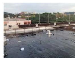
La réfection de la toiture du Mont Bouquet est en cours. Il s'agit d'assurer l'étanchéité totale de la résidence. Les travaux se poursuivront, sur ce bâtiment, par le changement des menuiseries, des interventions sur l'installation électrique et sur la VMC.
