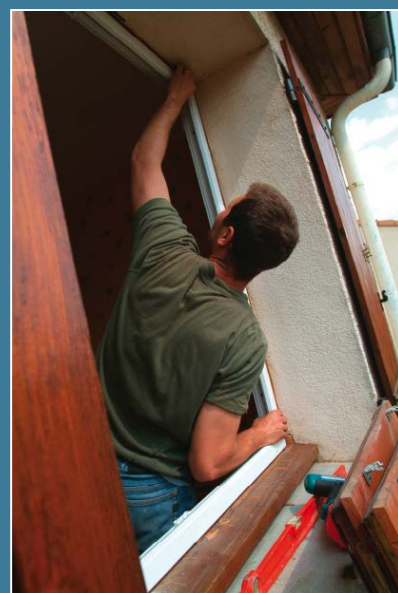
Les vieilles fenêtres sont remplacées par des menuiseries à double vitrage.
