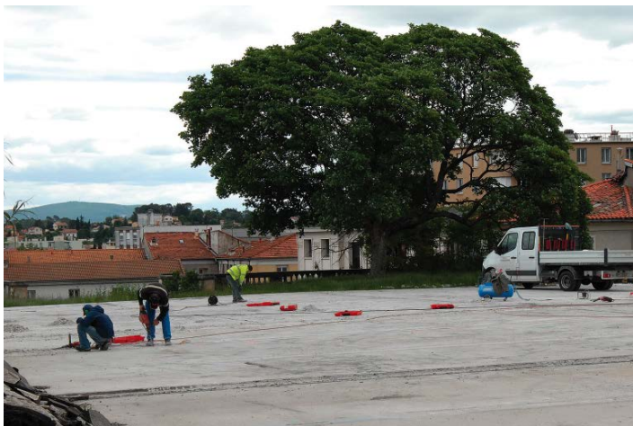
La dalle est préparée à recevoir la structure du multiplexe.
