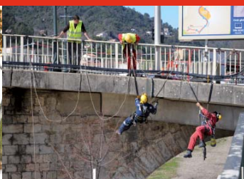
Installation du Très haut débit sur Alès et ses alentours.
