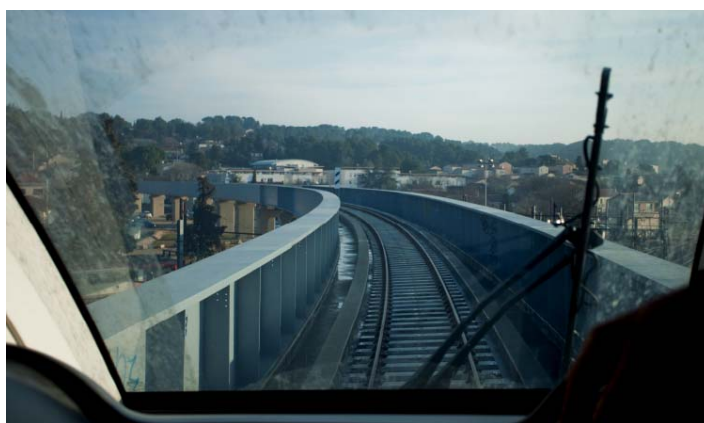
Le désenclavement d'Alès, notamment par le rail, est l'un des grands chantiers du Pôle métropolitain. Le 25 mars, les trains entre Alès et Nîmes ont enfin emprunté le viaduc de Courbessac qui réduit le trajet de 8 minutes et permet 4 aller-retours supplémentaires chaque jour.
