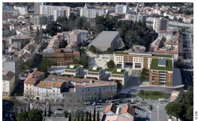
La transformation de la place des Martyrs de la Résistance sera le plus grand chantier urbain depuis trente ans.
