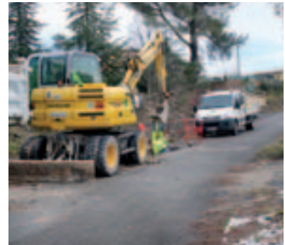
Les travaux ont commencé sur la route du Château d'eau.
