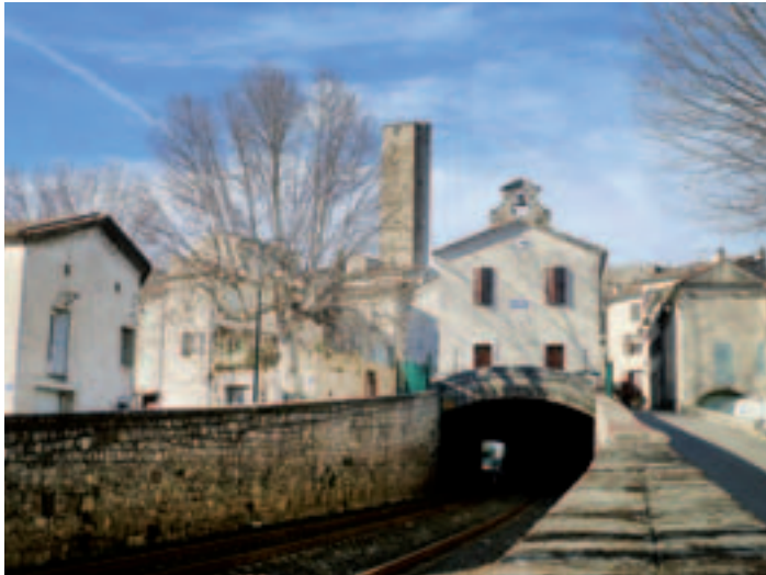
L'ancienne mairie à l'aplomb du tunnel ferroviaire.
