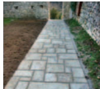
Le dallage facilite le passage entre les deux porches de la chapelle.
