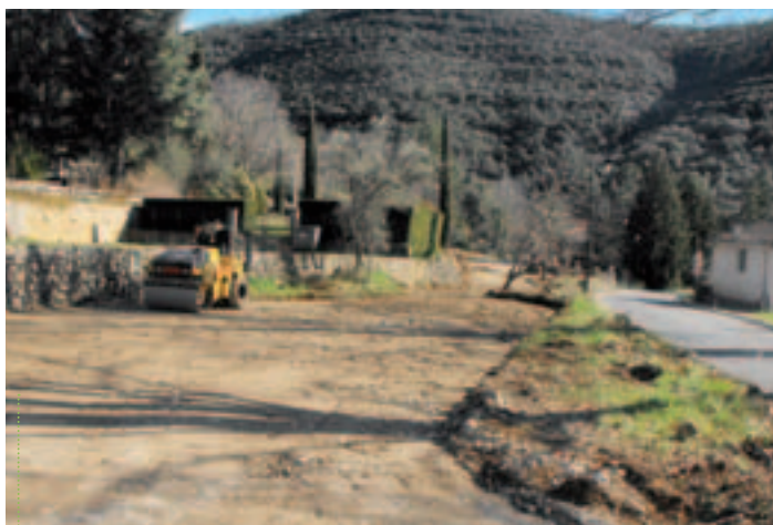
Une vue de l'état d'avancement des travaux.
