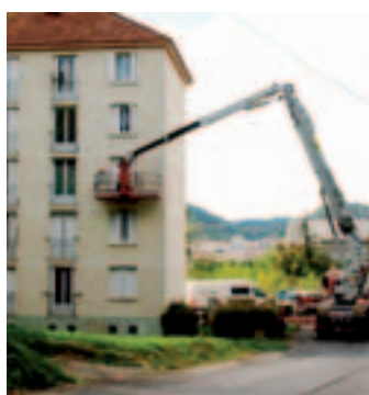
Les façades seront terminées cette année à Clavières.
