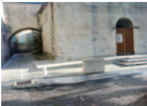
La rampe va faciliter l'accès à l'église des personnes à mobilité réduite.
