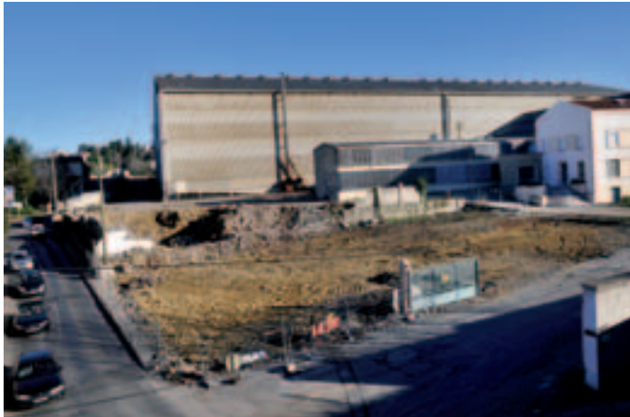
D'anciens bureaux ont été démolis pour gagner de la place en bas de la Montée de Silhol.
