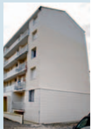
Isolation thermique par l'extérieur aux Cévennes.
