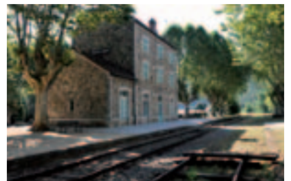
La gare, sur la ligne du TVC.
